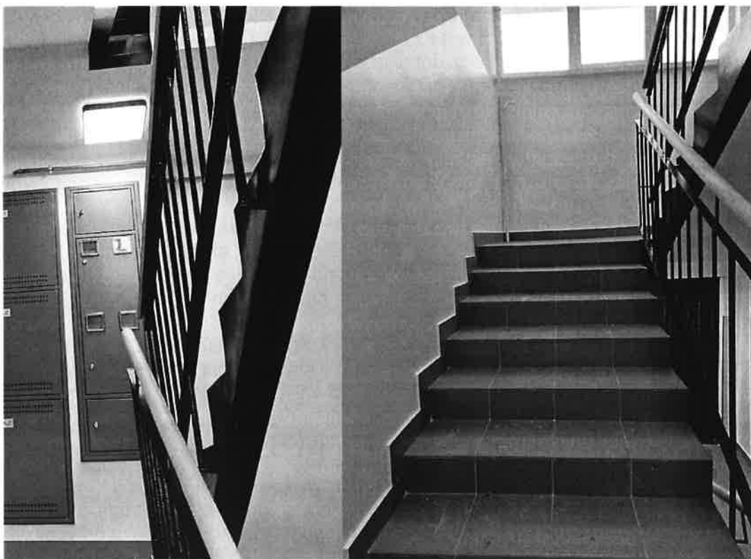
Wykończenie policzków i pas na biegu schodowym, wykończenie ścian – fot. pogładowa
